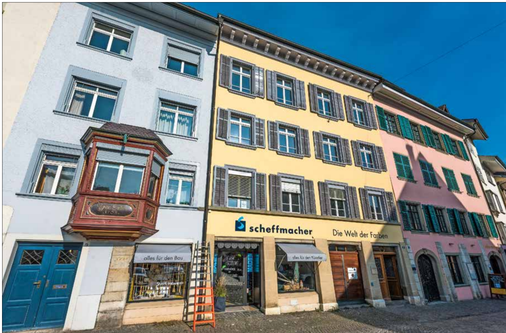
Die Fassaden der drei Häuser am Platz in der Schaffhauser Altstadt bilden einen harmonischen Dreiklang: hellblau, dunkle Vanillecreme und Erdbeerglace. Dani Scheffmacher hat als damaliger Präsident des kantonalen Malerunternehmerverbands an der Farbkarte für die Altstadt Schaffhausen mitgearbeitet.
