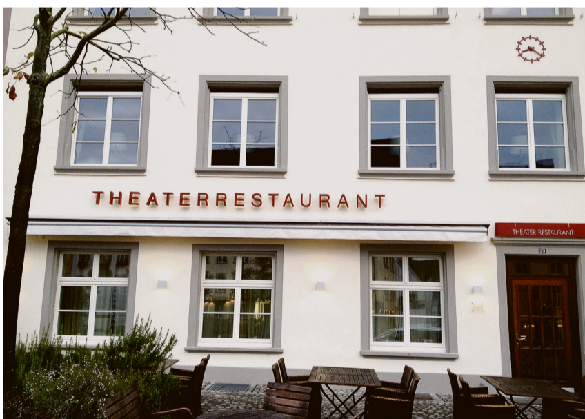
Renovation und Farbgebung von Alttadthäusern sind eine Herausforderung.
