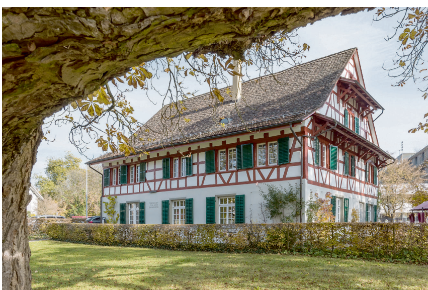
Nach seiner Sanierung strahlte das Restaurant Alter Emmersberg in neuem Glanz.
